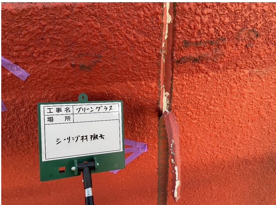
シーリング材撤去状況
