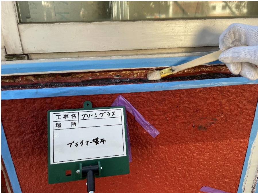
プライマー塗布状況
