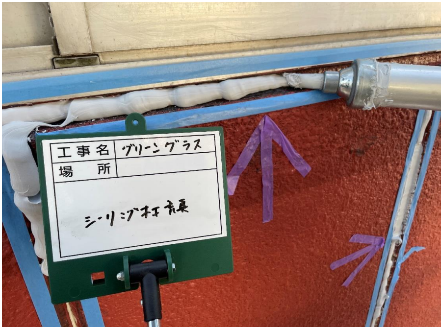
シーリング材充填状況
