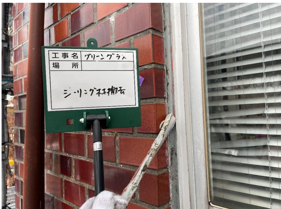
シーリング材撤去状況
